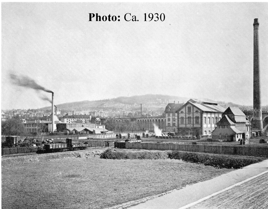
Abbildung 1 KVA Zürich an der Josefstrasse (ab 1904)
